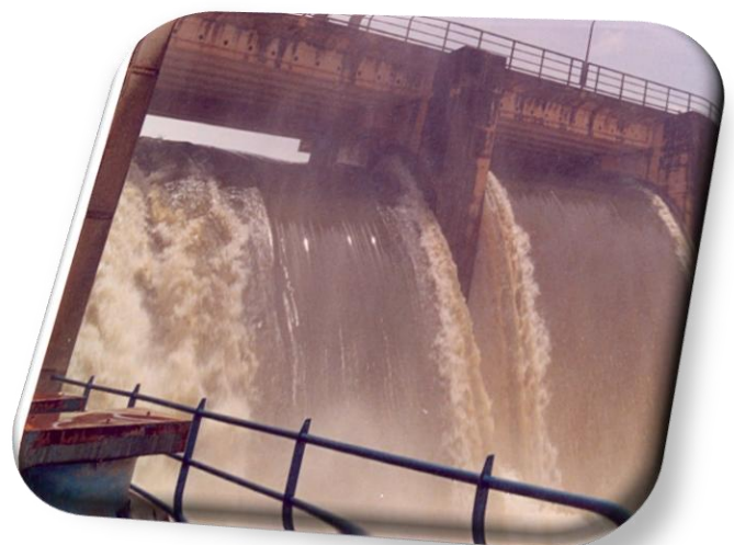
Centrale Hydroélectrique de Selingue
